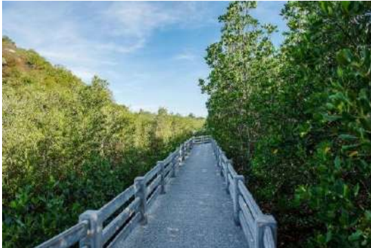
クライラー・ニュー・マングローブ生態系保護プロジェクト
